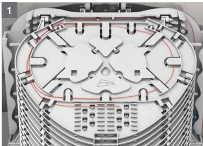
Die einzelnen Fasern auf der linken Seite (durch den Mischer) innerhalb der Spleißkassetten – Halterung zur jeweiligen Spleißkassette führen und die Ablage innerhalb der Spleißkassette vornehmen.
