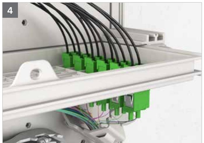
4 Kabel in Kupplung einführen.
