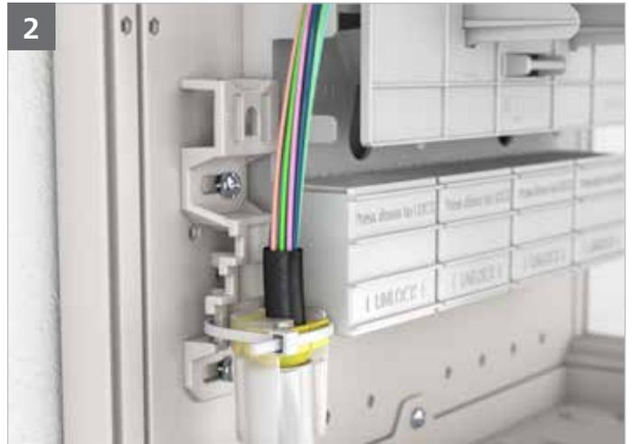
2 Hauptkabel auf die passende Leitungslänge absetzen.
