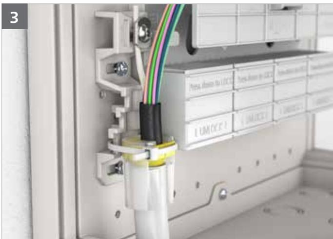
3 Gasstopper (Mikrorohr) mittels Kabelbinder an Zugentlastung (Provider) und FRP an Hammerkopf der Zugentlastung (Provider) befestigen.
