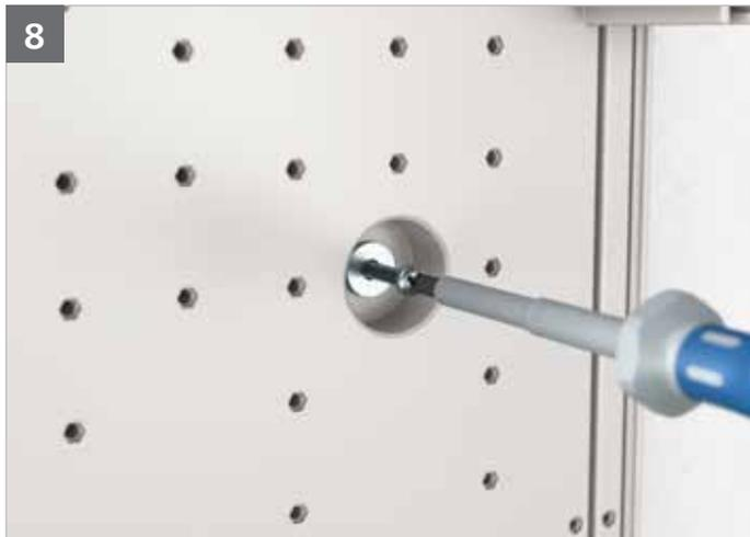
Gehäuse Unterteil an Wand anhalten und Schrauben mit Unterlegscheiben in den Dübel fixieren.
