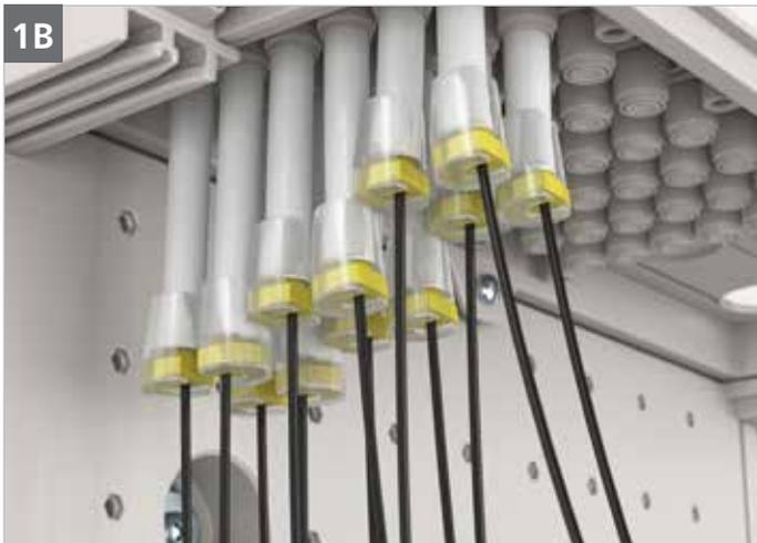
1B Die einzelnen Mikrorohre mit Gasblocker verschließen.
