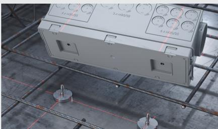
Fixation au moyen de l'aimant de retenue du système KAISER (n° art. 1299-69) ou de l'aimant de retenue du système KAISER PLUS (n° art. 1299-70).
