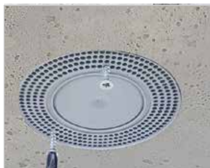
Universeller Decken- und Wandauslass
