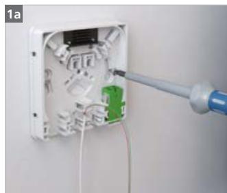
Mit Schrauben an der Wand befestigen.
