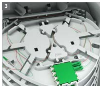
3 Glasfaserleitung in Patchkassette ablegen.
