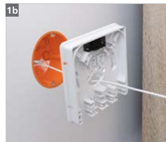
Mit Geräteschrauben auf der KAISER Einbaudose befestigen.
