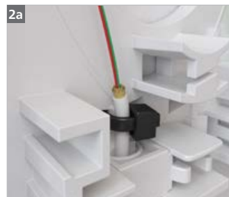
Glasfaserleitung befestigen und zugentlasten.
