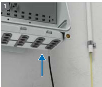
1 Glasfaserleitung in den Gebäudeverteiler einführen.
