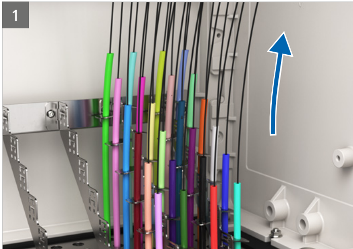
Kunden-Kabel durch Mikrorohre einblasen.
