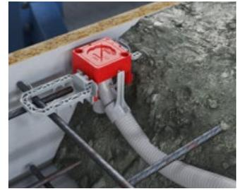
Während des Betoniervorgangs kann der Beton auch unterfließen und es verbleiben keine Befesti- gungsspuren in der rückseitigen Betonfläche.
