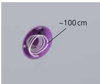
Glasfaserleitung zum Anschließen vorbereiten.
