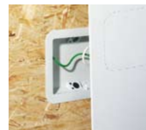
Installation mit OSB-Platte.
