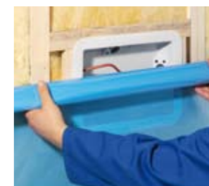
Installation mit innenliegendem Wechsel.
