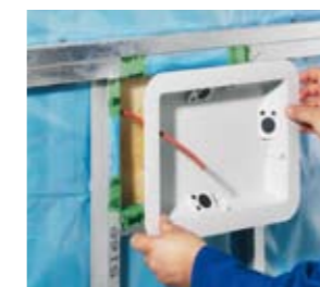
Installation mit aufliegenderm Wechsel.
