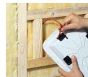
Installation mit innenliegendem Wechsel.
