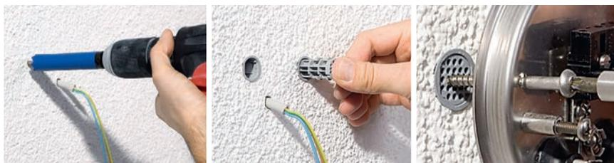
**Проширителят от твърдосплавен метал KAISER** (диаметър: 20 мм) пробива точни отвори в топлоизолационната композитна система (ETICS). В отвора се набива закотвящият дюбел, след което към него се монтира с притискане вътрешната част. В така монтираната мини конзола се навиват винтовете, което осигурява надеждното ѝ прилягане към топлоизолацията на фасадата.
