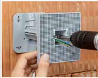
La fixation avant par vis et la butée de profondeur garantissent toujours un réglage précis et permettent ainsi d'éviter les erreurs d'installation.
