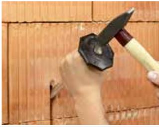
Préparer la fente du conduit. Un passage direct à travers la maçonnerie ne garantit pas une bonne isolation
