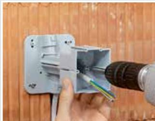
La fixation avant et la butée de profondeur garantissent toujours un réglage précis et permettent ainsi d'éviter les erreurs d'installation.
