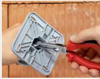
Briser les rondelles afin de permettre un passage direct du conduit.
