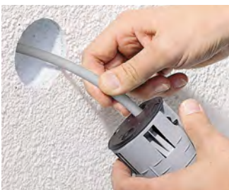
Die werkzeuglose und winddichte Leitungseinführung vermeidet Zugluft entlang der Leitung.
