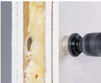
Installationsöffnung \varnothing 35 mm z. B. mit dem KAISER Fräser MULTI 4000 (Art.-Nr. 1082-10) erstellen.
