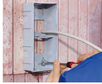
Gehäusebasis auf der Wand festschrauben.
