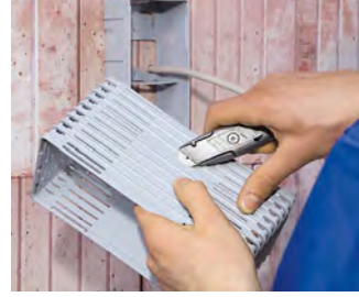
Aufstockelement ggf. an die Dämmstärke anpassen.
