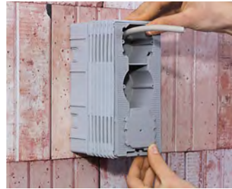
Den Kombinationseinsatz aufsetzen (Verschlussclip unten) und einrasten.
