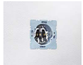
Dichtungseinsatz und Einbaugerät in die Dose drücken und mit Geräteschrauben befestigen.
