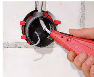
Mantel und Schirm der Leitung mit AMZ 2 (Art.-Nr. 1190-02) entfernen. Blanken Beidraht mit transparentem Isolierschlauch versehen.
