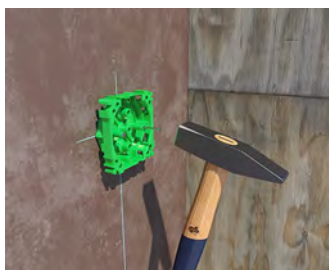
Frontteil an der Arbeitsschalung befestigen.
