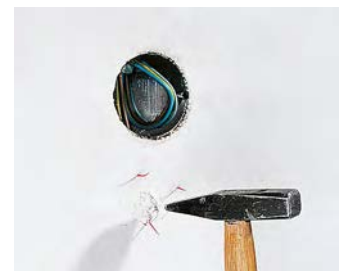
Die genaue Position der Gerätedose zeigen nach dem Verputzen die feinen Markierungsborsten des Signaldeckels an.
