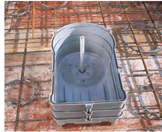
Gehäuse mit 2 Zwischenrahmen und Stützrohr auf der Schalung fixieren.
