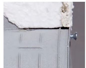
Die umlaufende Dichtlippe dichtet das WDVS ab, so dass keine Feuchtigkeit eindringen kann.
