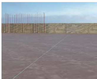
Die genaue Position der Deckendosen erfolgt mittels Schnurstrich oder spannen einer Maurerschnur.
