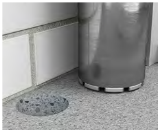
Erstellung einer Kernlochbohrung 150 mm oder 100 mm.
