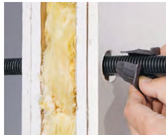
Für die Montage das Schott seitlich öffnen und über das Rohr schieben.
