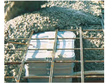
Sicherer und fester Sitz der Gehäuse beim Betonieren.
