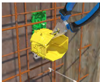
Rohreinführung öffnen.
