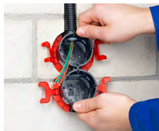
Dose mit aufgerastetem KLEMMFIX® einsetzen.
