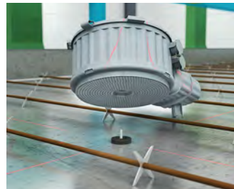
...Montage des einteiligen Gehäuses mittels Haftmagnet (Art.-Nr. 1299-67).
