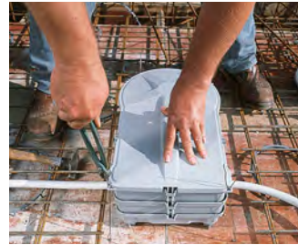
Gehäuse zusätzlich an der Bewehrung sichern.
