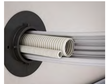
Mantelleitungen und Rohre durch den Schottzylinder führen.
