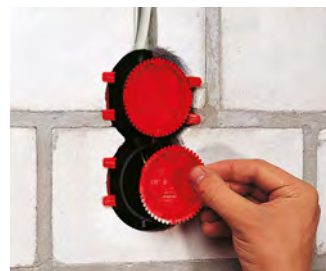
Signaldeckel aufsetzen.
