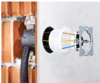
Nachträgliches, luftdichtes Verschließen von Unterputzdosen.
