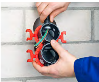
Einbauöffnung herstellen.
