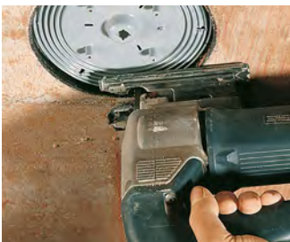
Frontteil mit einer Stichsäge öffnen.
