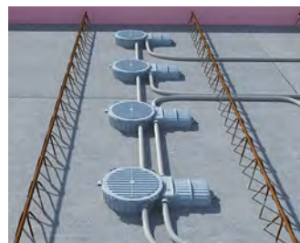
Nach dem Verrohren erfolgt die Betonierung auf die geplante Deckenstärke im Ortbetonverfahren.
