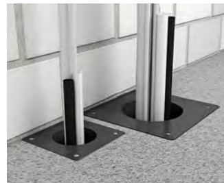
Mantelleitungen und/oder Rohre durch die Montagehülse führen.
