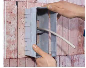
Aufstockelement aufsetzen und einrasten.
