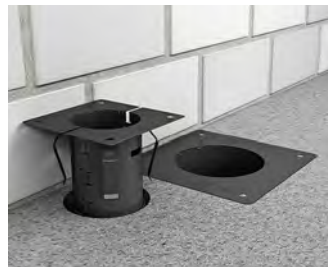
Einsetzen der Montagehülse von der Deckenoberseite.
