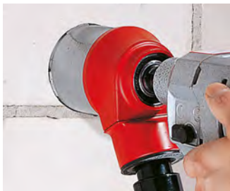
Passgenaue Wandöffnung (Ø 82) mit Diamant-Schleifkronen erstellen.
