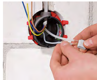
Funktionserder der Dose mit den Beidrähten der geschirmten Leitung verbinden.
