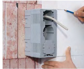
Nun kann die Dämmung angepasst und montiert werden.
