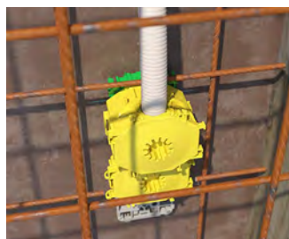
Rückteil mit Rohr auf das Frontteil aufrasten, anschließend betonieren.
