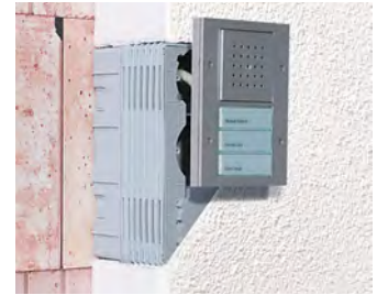
Nach Aufbringen der Putzschicht das gewünschte Gerät einsetzen.
