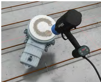
Montage des einteiligen Gehäuses mit Mineralfaserplatte...
