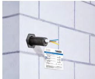
Wanddurchführung durch Brandschutzwand aus Kalksandstein.
