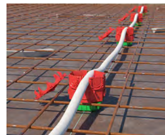
Vorteil der neuen Rohreinführung, die Leerverrohrung mehrerer Decken-Verbindungs-dosen in einer Flucht, kann durch einfaches Einlegen des Installationsrohres erfolgen ohne dieses vorher zu schneiden.
